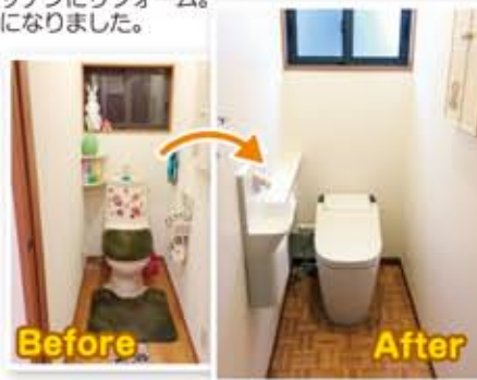
<トイレリフォーム>
