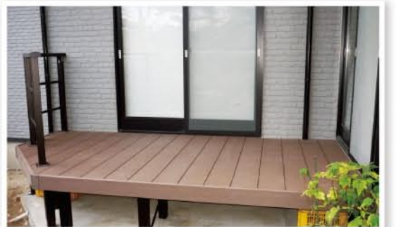
<ウッドデッキ工事> 広い庭のスペースを利用し、ウッドデッキを設置。家族みんなでバーベキューや芋煮会が楽しめます。
